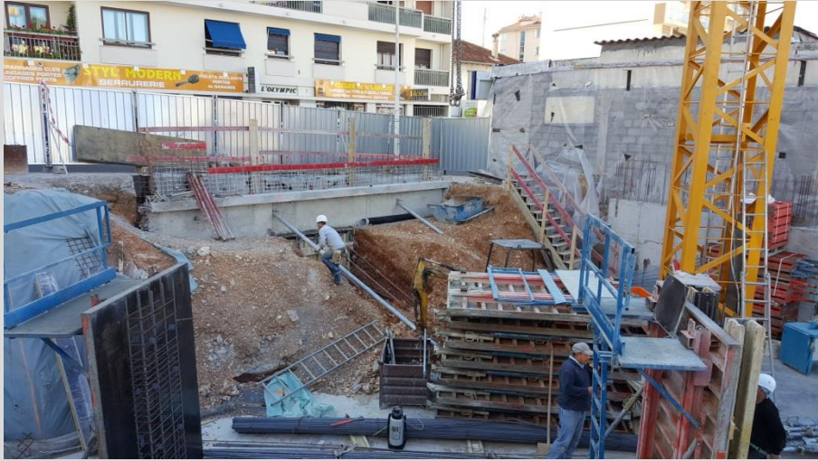
Coulage reprises en sous-cœvre
