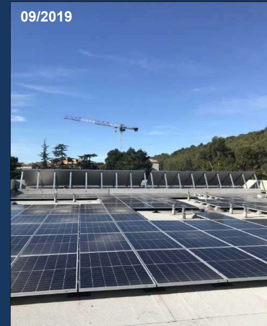
Pose capteurs solaires Thermiques et photovoltaïques
