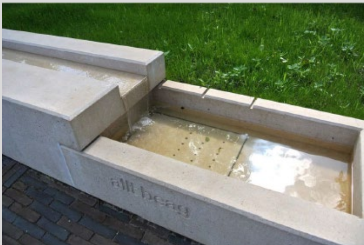
Canal béton blanc – modules préfabriqués
