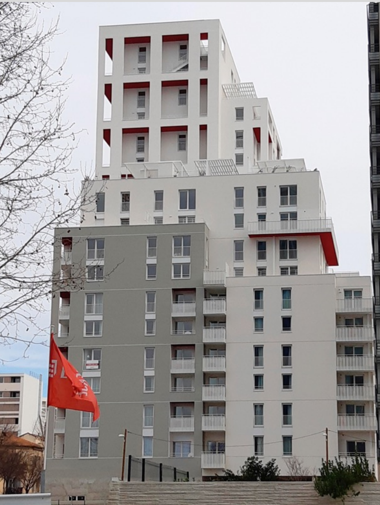
Façade Ouest rue Peyssonnel
