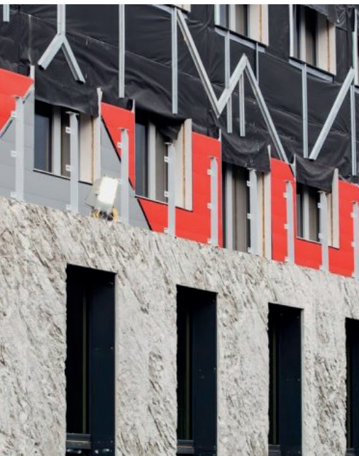
Siège social du groupe Barel et Pelletier à Mery (73), Barbeyer Architecte / Utilisation de panneaux préfabriqués mixte bois-béton ©Jean-Louis Sevez
