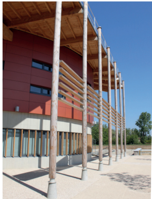
Collège de Beaumont les Valence (26), Chabal architecte / Bâtiment d'enseignement niveau E4 construit avec des produits certifiés Bois des Alpes - ©TRIBU
