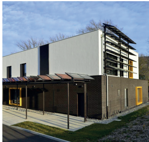
Pôle Médico-Social de Seynod (74), Bâtiment conçu à énergie positive tous usages mais atteignant le niveau E3. La méthode actuelle ne valorise pas les efforts réalisés sur la réduction des consommations des équipements. ©DJA-Pierre Vallet
