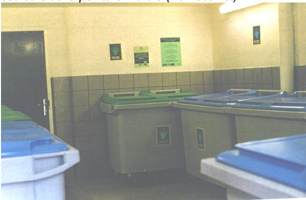
Aménagement de local : agrandissement, carrelage, équipements techniques (Bagnolet)
