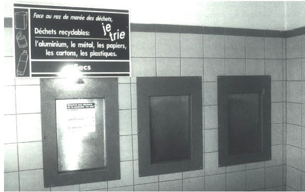
Aménagements de trappes passe-paquets dans le hall d'entrée (Echirolles)
