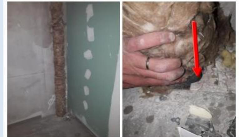
Passages d'air par les réservations des planchers intermédiaires dédiés au passage de réseau techniques : EC d'alimentation des radiateurs et EU.
