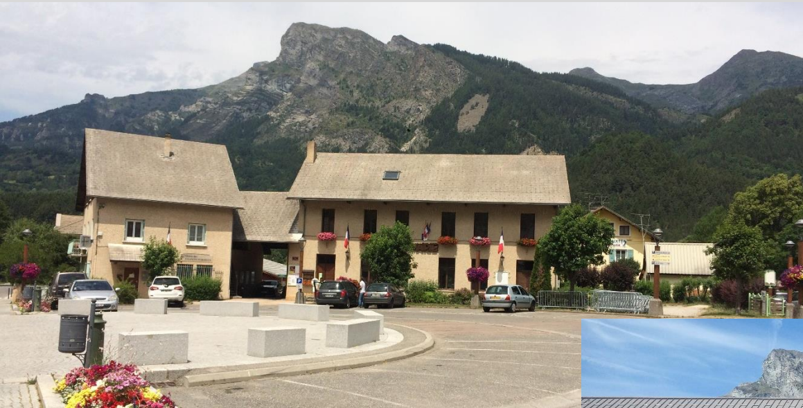
Avant travaux 11 Juillet 2016
