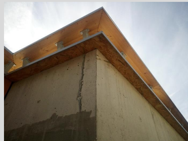
Débord de couverture avec réserve pour ITE
