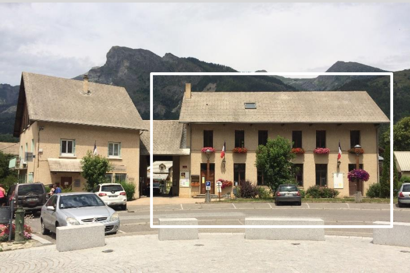
Mairie avant travaux
