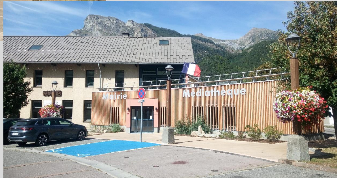
Après travaux 24 Septembre 2018
