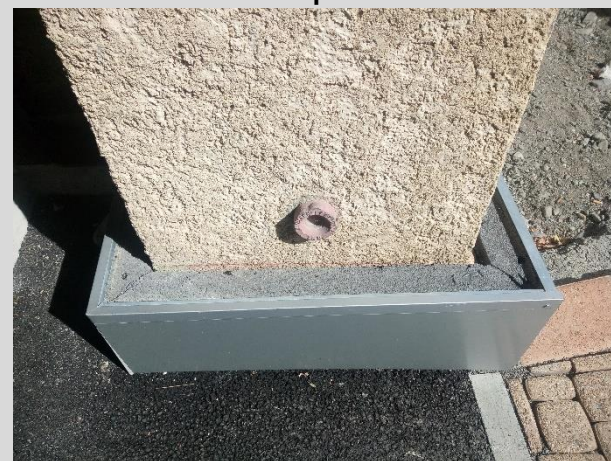
Isolant en pied de façade avec réserve pour ITE
