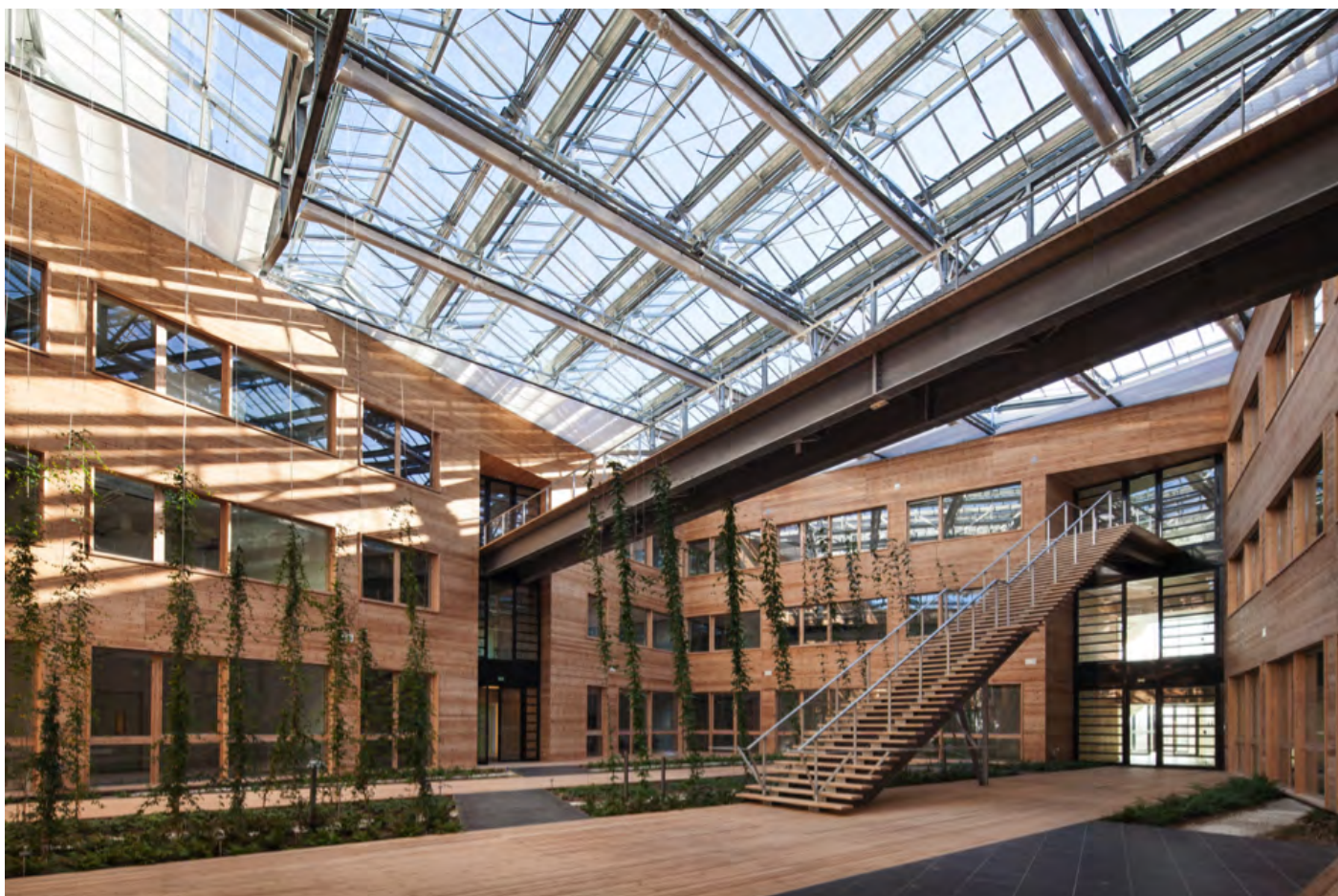
Institut National de l'Énergie Solaire à Chambéry (73). Ce siège s'inscrit dans le paysage urbain de la technopole de Chambéry. La volumétrie générale, l'orientation des baies et leurs équipements sont conçus pour se protéger des rayons solaires d'été, optimiser les apports solaires gratuits en hiver et assurer la ventilation optimum des volumes. Les brise-soleils motorisés de la façade ouest « accompagnent le rythme du soleil, comme des tourmesols ». Ce bâtiment consomme 25Kwh/m 2 par an pour se chauffer. Grâce à 300 m 2 de capteurs solaires thermiques complétés par une chaudière à granulés de bois, auxquels viennent s'ajouter 400 m 2 de cellules photovoltaïques, il accède au statut de bâtiment à énergie positive. Architectes : Michel Rémon, mandataire et Frédéric Nicolas
