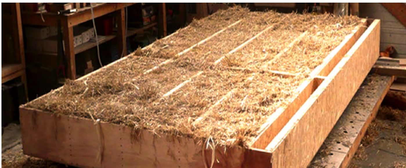
Atelier relais de l'ONF à Barrême (05). Ce bâtiment est réalisé en bois local et certifié « bois des Alpes ». Les parois sont en caissons isolés en bottes de paille. La structure est constituée de poteaux ronds écorcés, d'arbalétriers en bois lamellé-collé avec sous tension métallique et la toiture est isolée en ouate de cellulose posée entre les pannes. F Nicolas, architecte et la SCOP Gaujard technologie, bureau d'études spécialisé en structures bois et enveloppes en matériaux biosourcés.
