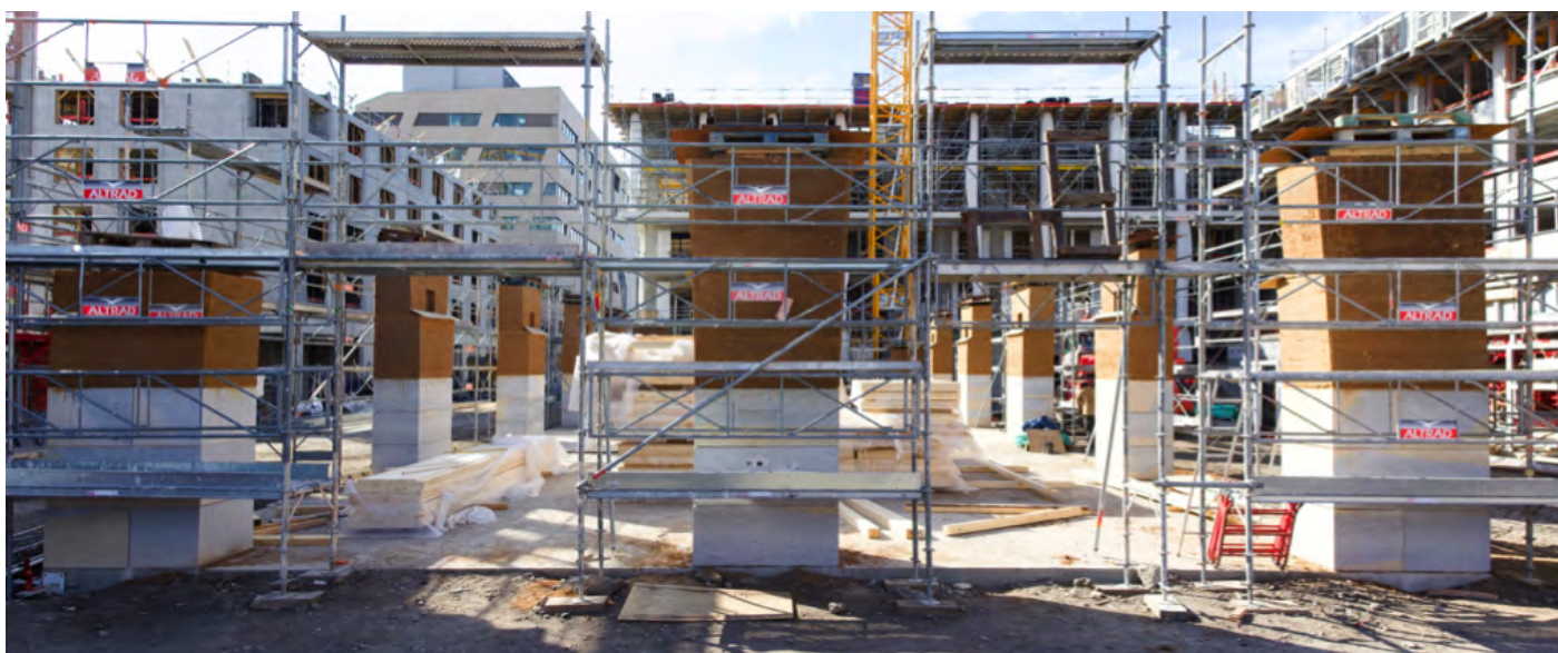
Immeuble de bureaux de L'Orangerie, Lyon-Confluence (69). Cette opération de bureaux est conçue à partir d'une structure en pisé. Les terres utilisées sont issues de chantiers situés à Saint-Quentin-Fallavier à 30 kilomètres de Lyon. Nous sommes là dans un processus 100% recyclé et recyclable. L'atout du matériau pisé est la qualité de l'hygrothermie (température et taux d'humidité de l'air ambiant d'un local) qu'il permet grâce à la présence d'argile. Celui-ci absorbe l'humidité ambiante. Même sec, le pisé contient à minima 1 % d'eau (7 % à 8 % quand il est humide). Quand il fait froid, la condensation entraîne un réchauffement du matériau qui permet de maintenir l'intérieur plus longtemps. Jusqu'à 2 mois de chauffage peuvent ainsi être économisés chaque année par rapport à une construction classique. A l'inverse, en été, l'humidité s'évapore et rafraîchit le bâtiment. Cette forme de climatisation naturelle chaud/froid fonctionne à condition de choisir des enduits appropriés pour laisser la terre respirer. Les planchers bois (stockage de CO 2 ) sont posés sur des voûtes achéménides (forme ne provoquant aucune poussée de forces vers l'extérieur, les dispensant d'armatures). Aujourd'hui, cette technique (qui représente près de 20 000 logements dans l'agglomération lyonnaise) autorise des constructions de deux à trois niveaux maximum. Clément Vergély et Diener & Diener, architectes, Bet Batsarf, Bet Structure pisé, Jean-Claude Morel, université de Coventry, Antonin Fabbri (Entpe) et Le Pisé (Nicolas Meunier), Entreprise pisé.
