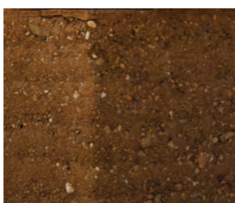
Immeuble de bureaux de L'Orangerie, Lyon-Confluence (69). Cette opération de bureaux est conçue à partir d'une structure en pisé. Les terres utilisées sont issues de chantiers situés à Saint-Quentin-Fallavier à 30 kilomètres de Lyon. Nous sommes là dans un processus 100% recyclé et recyclable. L'atout du matériau pisé est la qualité de l'hygrothermie (température et taux d'humidité de l'air ambiant d'un local) qu'il permet grâce à la présence d'argile. Celui-ci absorbe l'humidité ambiante. Même sec, le pisé contient à minima 1 % d'eau (7 % à 8 % quand il est humide). Quand il fait froid, la condensation entraîne un réchauffement du matériau qui permet de maintenir l'intérieur plus longtemps. Jusqu'à 2 mois de chauffage peuvent ainsi être économisés chaque année par rapport à une construction classique. A l'inverse, en été, l'humidité s'évapore et rafraîchit le bâtiment. Cette forme de climatisation naturelle chaud/froid fonctionne à condition de choisir des enduits appropriés pour laisser la terre respirer. Les planchers bois (stockage de CO 2 ) sont posés sur des voûtes achéménides (forme ne provoquant aucune poussée de forces vers l'extérieur, les dispensant d'armatures). Aujourd'hui, cette technique (qui représente près de 20 000 logements dans l'agglomération lyonnaise) autorise des constructions de deux à trois niveaux maximum. Clément Vergély et Diener & Diener, architectes, Bet Batsarf, Bet Structure pisé, Jean-Claude Morel, université de Coventry, Antonin Fabbri (Entpe) et Le Pisé (Nicolas Meunier), Entreprise pisé.
