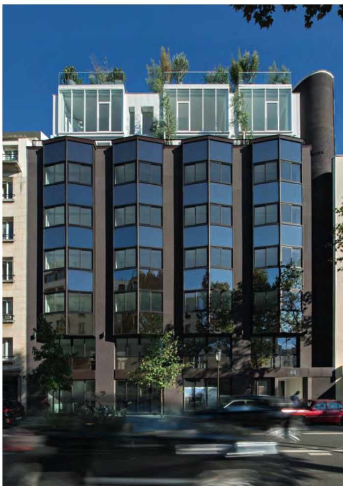
Les « maisons sur le toit », immeuble de bureaux, Boulogne-Billancourt (92). La ville se densifie (surélévation, creusement des sous-sols, construction en coeurs d'îlots, etc.) et offre un nouveau paysage urbain. Ici le projet de surélévation de cet immeuble implanté sur rue en est une illustration probante et intéressante. Ces nouvelles maisons sur les toits, en densifiant la ville, offrent une nouvelle façon de vivre les paysages urbains de l'après-pétrole. Vincent Eschaler architecte, photographies Nicolas Mathéus.
