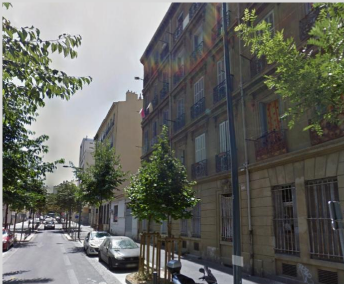
Environnement lointain - Rue Peyssonnel
