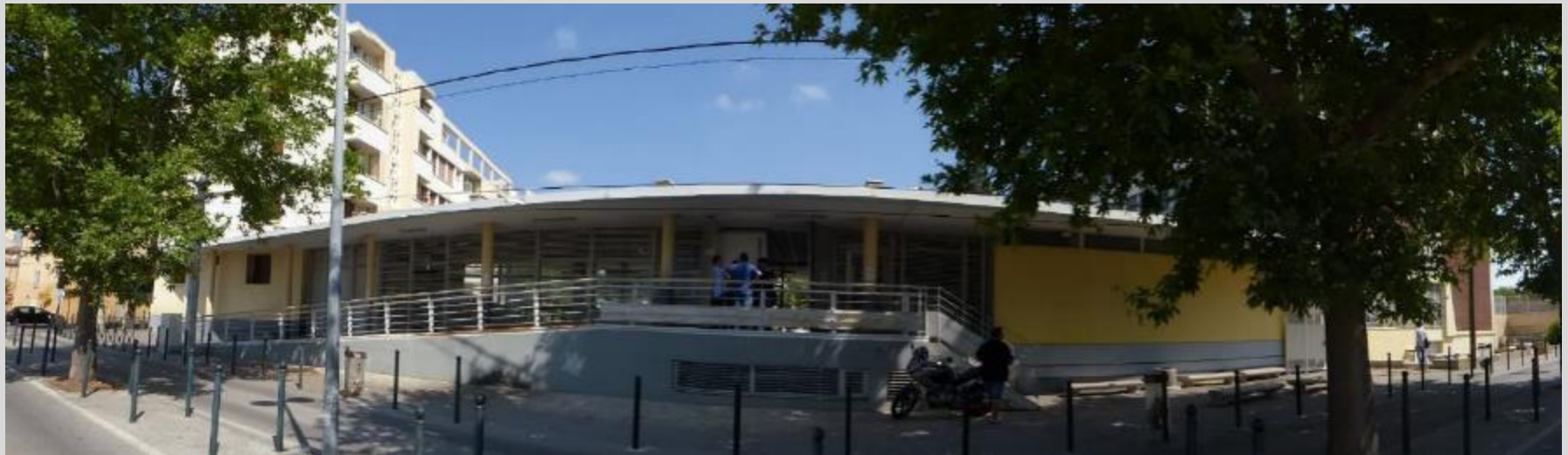
Bâtiment H – Entrée future générale – Impasse Gallet Cantant – accès chantier
