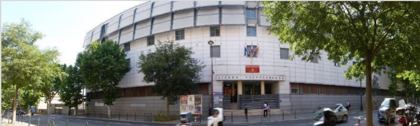
Bâtiment E – Entrée actuelle Administration/Enseignants – Boulevard Carnot
