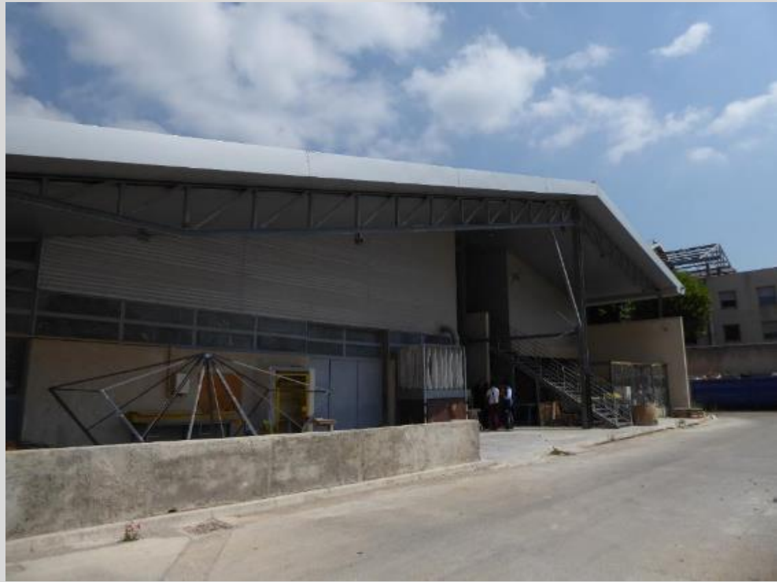
Façade Sud Bâtiment J
