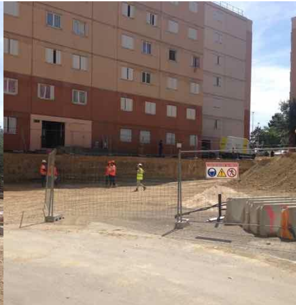
Noues et bassins de rétention
