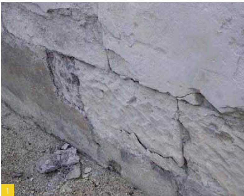
Photos Cerema Dler Ouest
