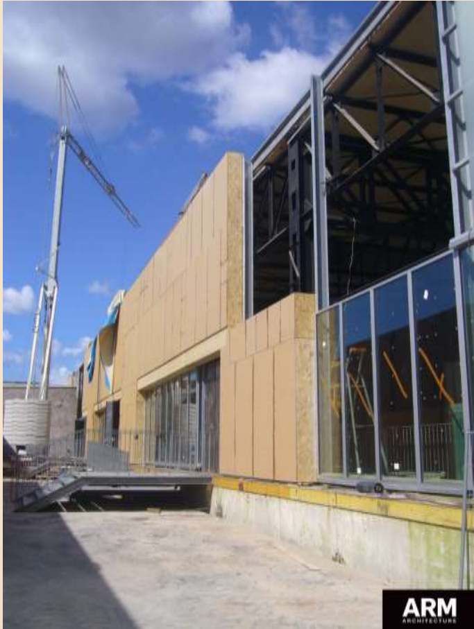
↑ Pose des caissons autoporteurs
