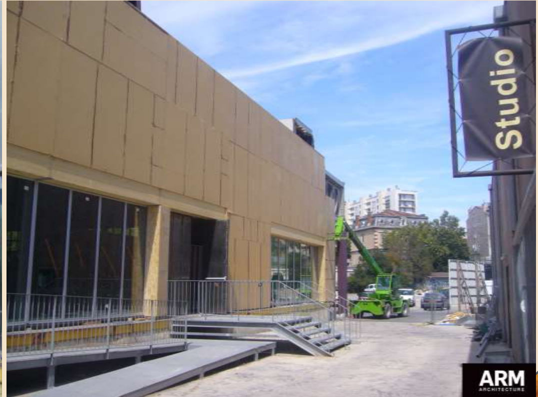
↑ Adaptation aux sheds et pose des couvertines
