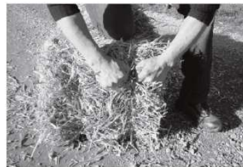
L'opération est répétée sous chaque ficelle et sur chaque face aux deux bouts de la botte.
