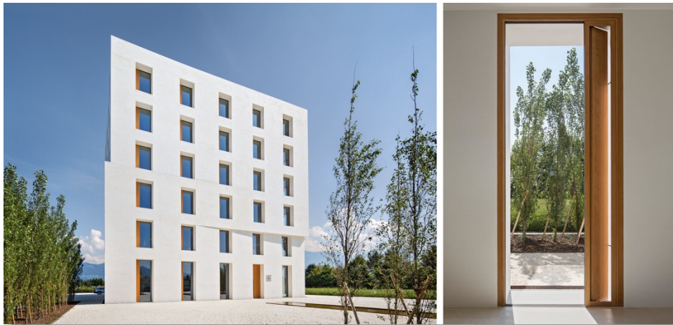
Figure 4 - immeuble 2226 : vue générale et des ouvertures, source E. Hueber ( archphoto.com )
