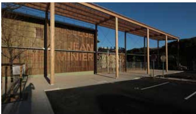
Ouvrage neuf livré en février 2018, le collège de l'Estérel à Saint-Raphaël présente une isolation thermique par l'extérieur en fibre de bois et des protections solaires adaptées aux orientations des différentes façades (verticales, casquettes et films solaires). La stratégie pour le confort
