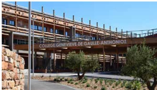
Le collège Geneviève De Gaulle-Anthonioz à Carcès, livré en juillet 2017, applique les mêmes principes bioclimatiques que ceux précédemment présentés (isolation thermique extérieure, protections solaires adaptées aux orientations, etc.). Le confort thermique d'été est assuré notamment par une CTA double flux et des ouvrants de ventilation naturelle asservis pour les verrières du bâtiment d'enseignement général et du gymnase, ainsi que par un système de « geocooling ».
