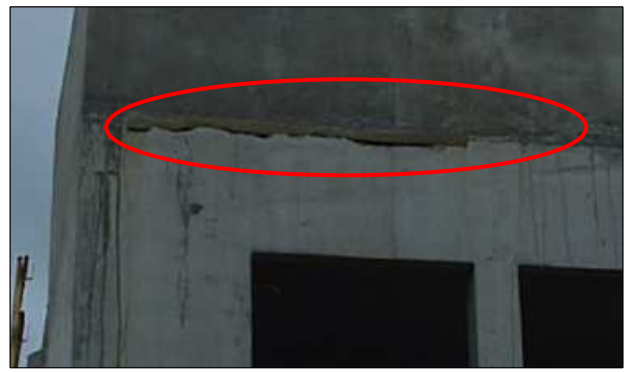
Rupture du pont thermique au niveau des acrotères avec 4 cm de laine de roche
