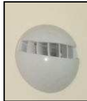
Grille d'insufflation double flux
