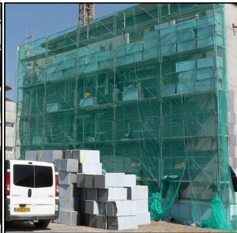
Bâche anti-UV installée lors de la pose de l'isolant
