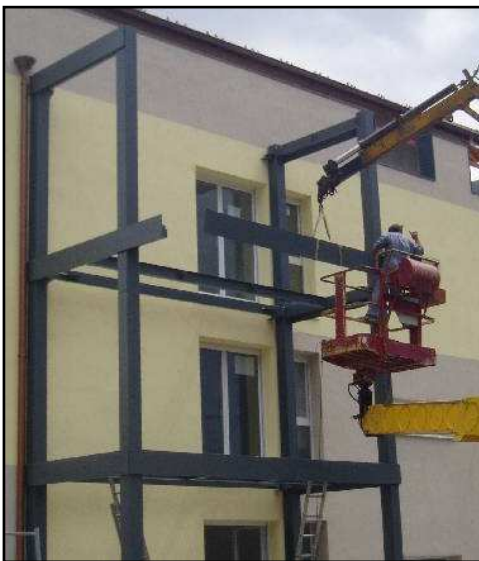
Pose de la structure métallique en cours sur un des bâtiments de SOGIMM Maurice Monod Constructeur le 07/07/09
