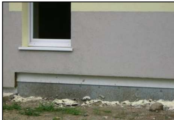
Isolant enterré sur 1m
