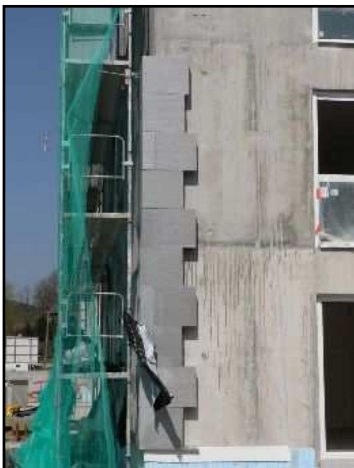
Bâche anti-UV installée lors de la pose de l'isolant
