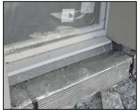
2 cm de PSE sous les seuils de portes fenêtres
