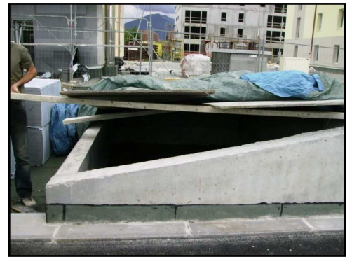
Trappe d'alimentation du silo, donnant sur rue
