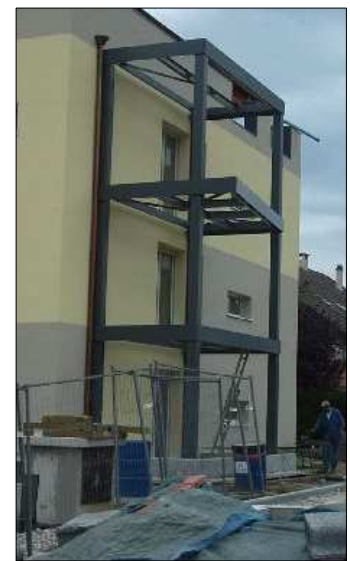
Pose de la structure métallique en cours sur un des bâtiments de SOGIMM Maurice Monod Constructeur le 07/07/09
