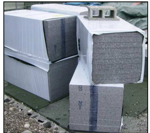
Il ne faut ouvrir l'emballage des isolants qu'au dernier moment (emballage anti-UV)
