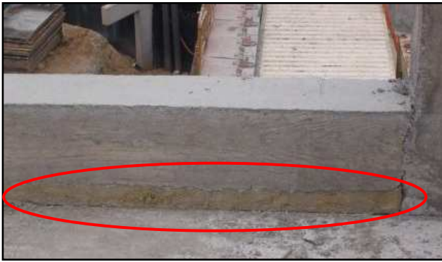
Rupture du pont thermique au niveau des acrotères avec 4 cm de laine de roche
