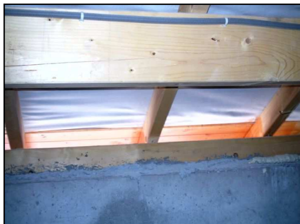
Mousse expansive sous la sablière
