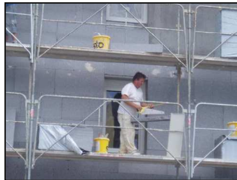
Artisans effectuant la pose de l'isolant – photos prises sur le chantier le 07/07/09
