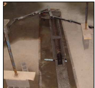
Le silo, avec au fond les pales rotatives et une vis sans fin – 31/03/09, source : Etamine
