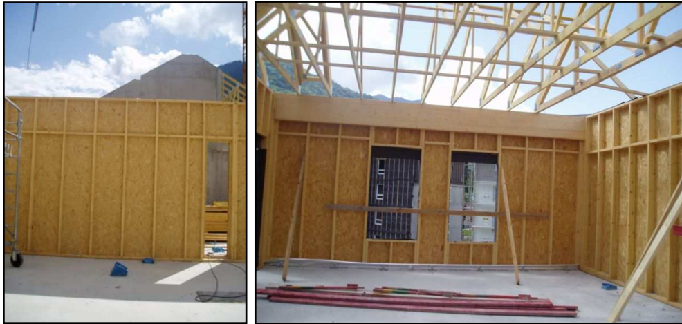
Bâtiment D - Panneaux bois formant l'ossature du dernier étage
