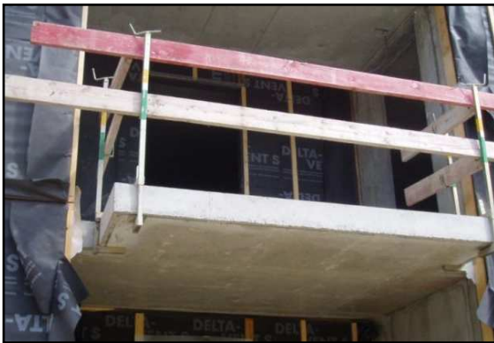
Dalle d'un balcon sur le bâtiment D
