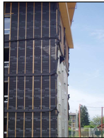
Bâtiment C, façade Nord
