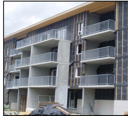
Bâtiment C - Balcons achevés
