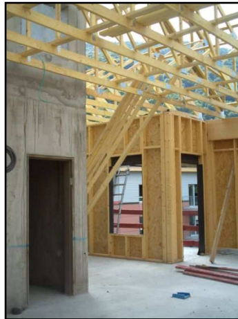
Bâtiment D - Panneaux bois formant l'ossature du dernier étage
