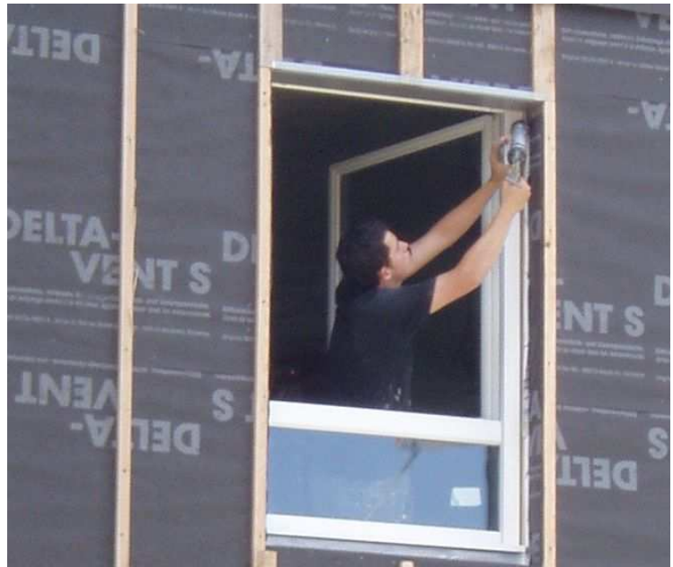
Mise en place de mastic aux jointures extérieures de la menuiserie
