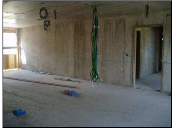
A l'intérieur, refends et dalles sont en béton armé
