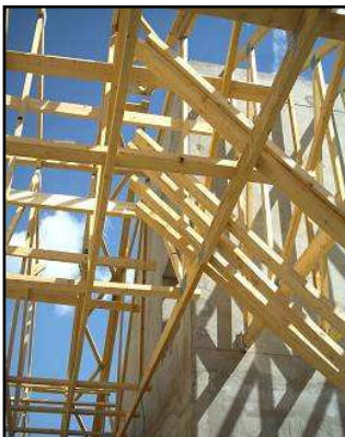
Bâtiment D – La charpente vue depuis le dernier étage
