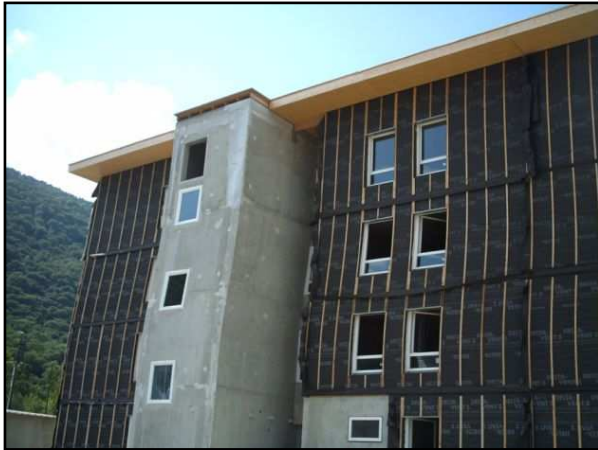
Bâtiment C, façade Nord. On distingue l'ossature en béton sous les panneaux bois en cours de pose
