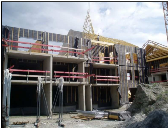
Bâtiment D, façade Sud - La pose des panneaux bois vient d'être achevée
