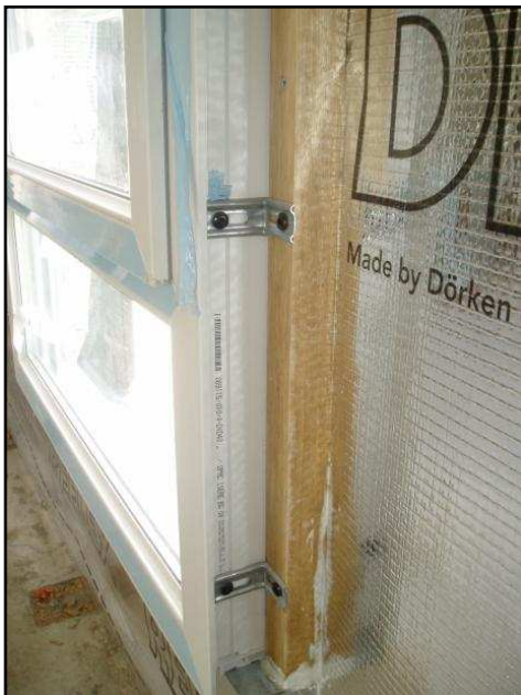
Menuiserie partiellement encastrée dans le panneau bois
