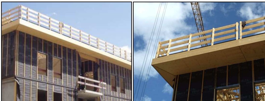
Bâtiment A, façade Sud - Tête de panneau venant d'être posée
