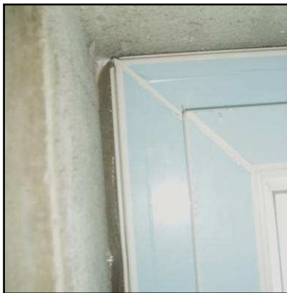
Détail d'utilisation de compribande sur les menuiseries
