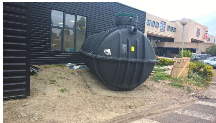
Cuve de récupération enterrée de 20m 3
