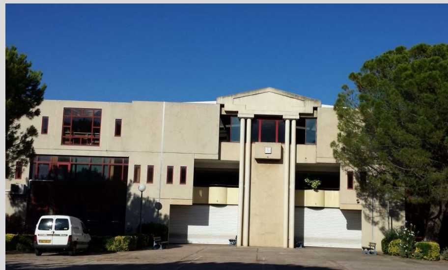
Façade Sud-Ouest : Avant / Après
