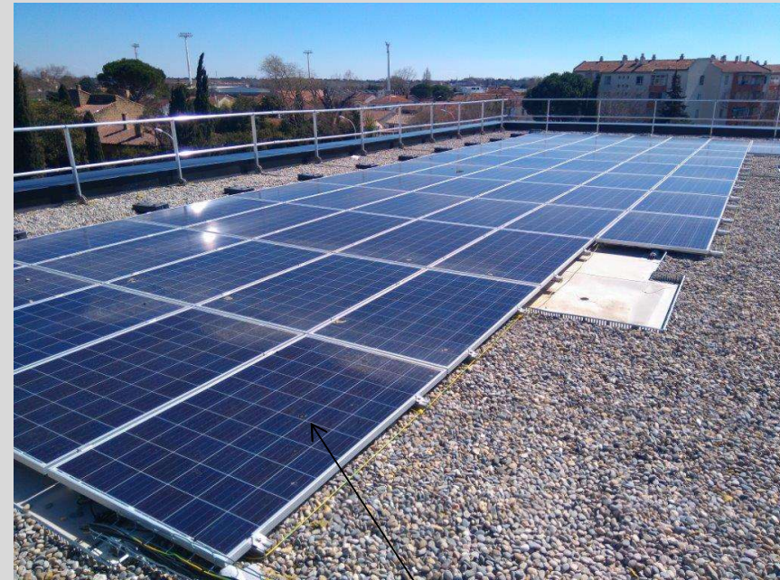
Installation photovoltaïque sans support d'inclinaison afin de ne pas alourdir la toiture
