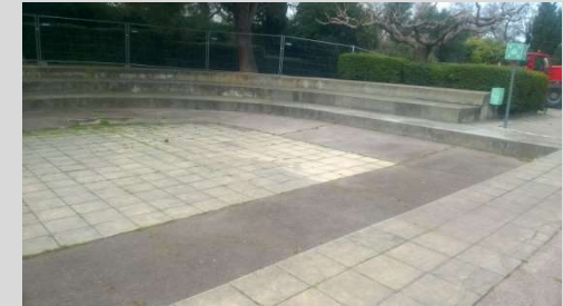
Théâtre extérieur avant réalisation de la dalle
