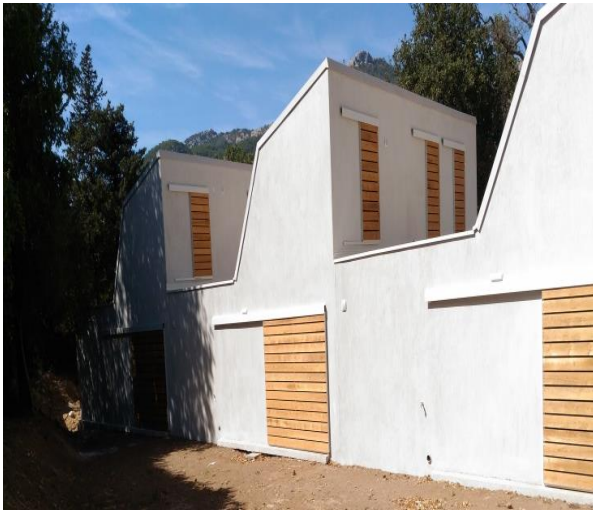
2. Vue sur la façade Sud du projet ©EnvirobatBDM
