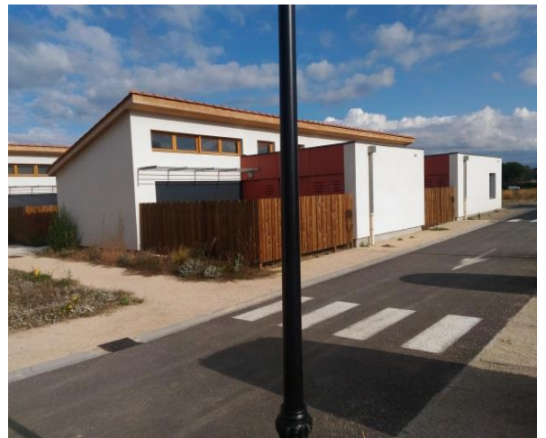
3. Vue sur la façade Sud ©EnvirobotBDM
