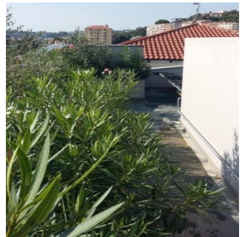
3. Toiture végétalisée ©Logis Familial
