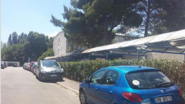
Vue du bâtiment 2 depuis l'allée au sud
