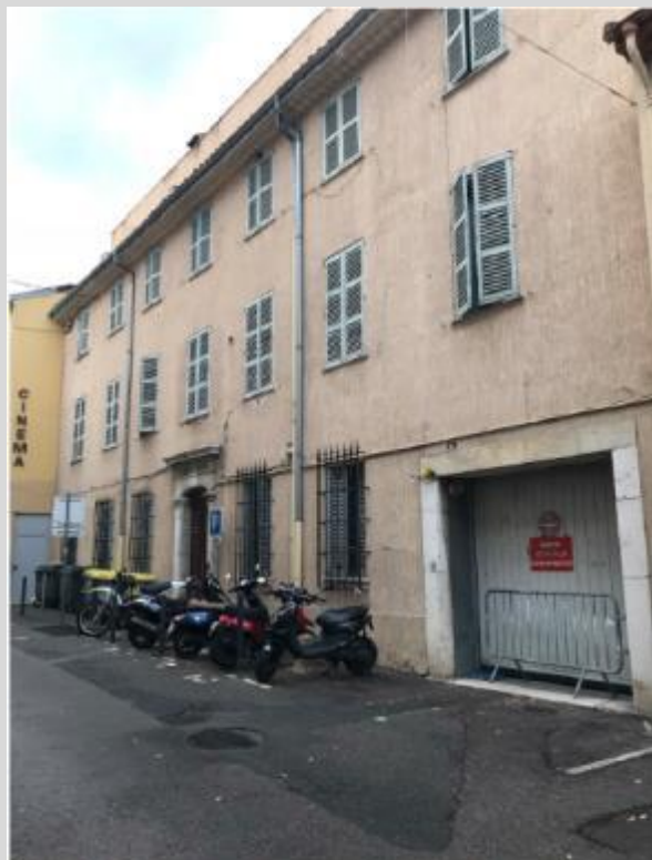
Façade Sud bâtiment Ancienne Gendarmerie sur Rue Henri Isnard
