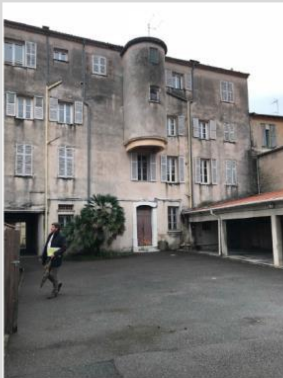
Façade Nord bâtiment Ancienne Gendarmerie sur cour
