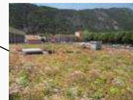
Toiture végétalisée Toundra
