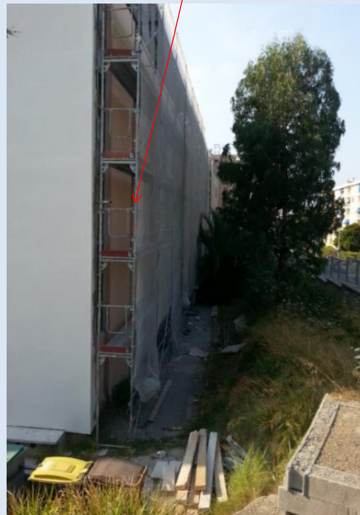
Echafaudage avec filet
