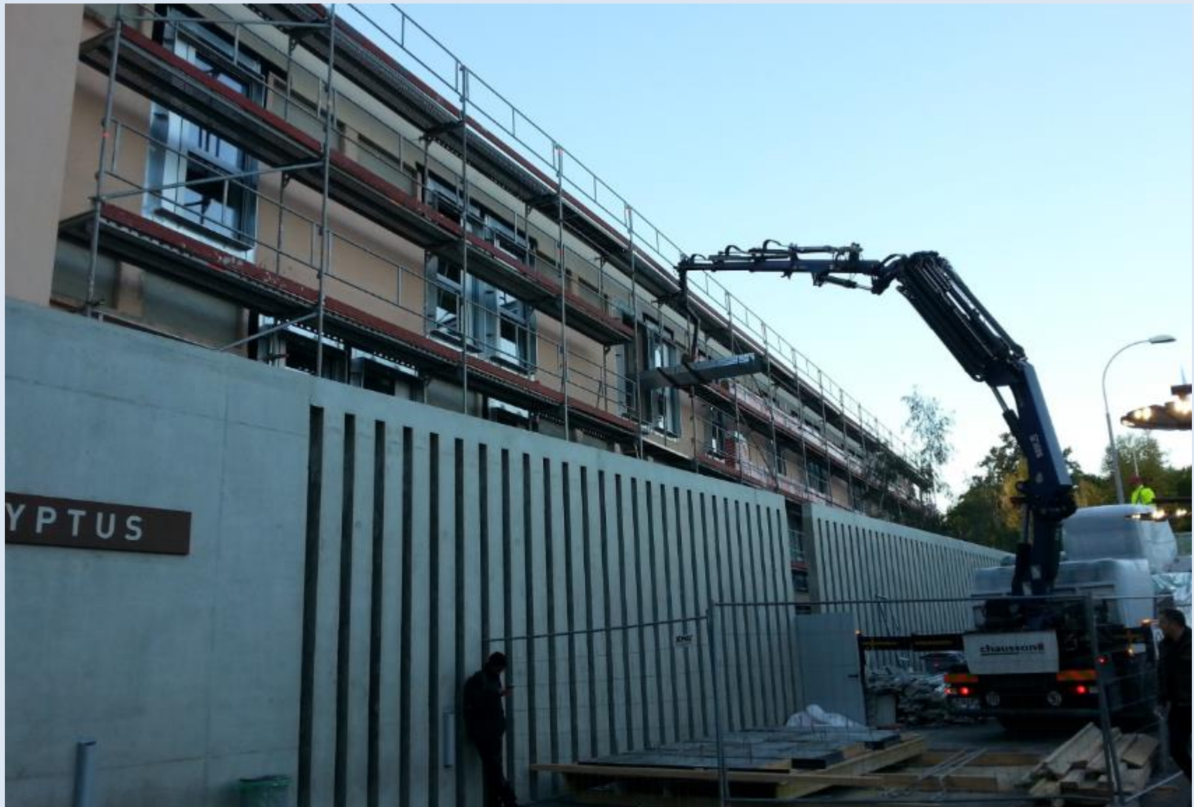
Site occupé engendrant des difficultés en terme de livraisons
