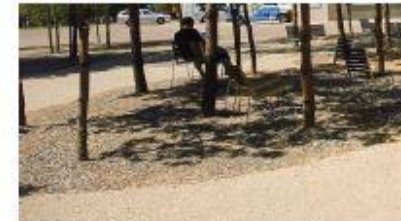
Béton et stabilisé gravillonné pour le parvis
