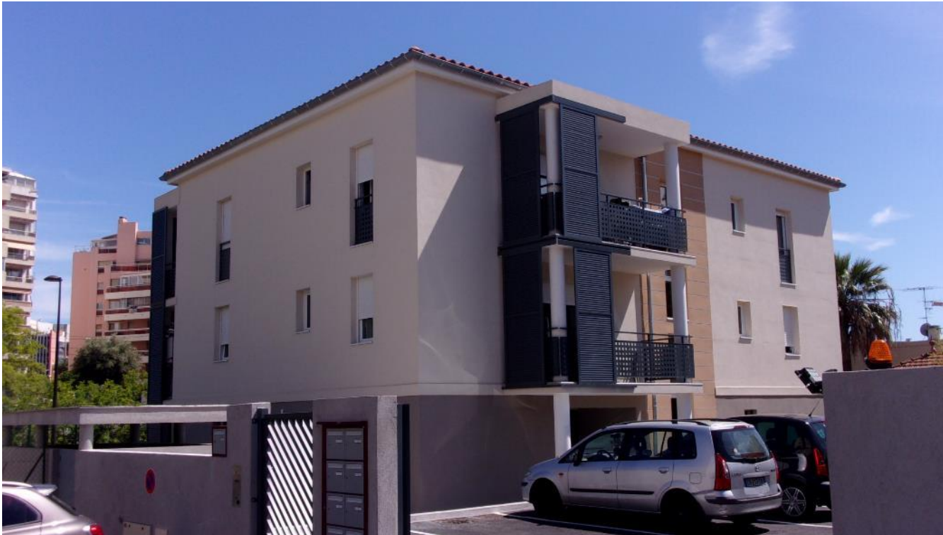
Façades Ouest et Nord
