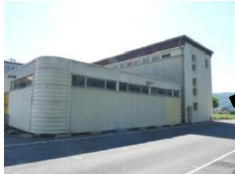
Bâtiment B exposition NO Atelier au premier plan
