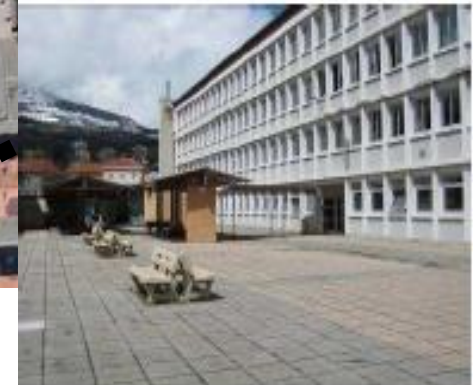
Bâtiment A en R+3, façade sud ouest Cour
