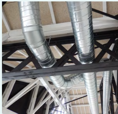
Adaptation des réseaux aérauliques sur la structure existante
