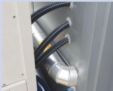
Passages de gaines dissociés et étanchés par du mastic et du silicone
