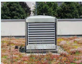
Tourelle de ventilation en toiture
