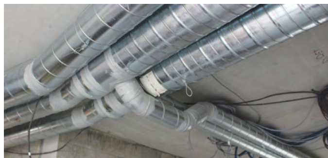
Multiplication de singularités sur un réseau aéraulique
