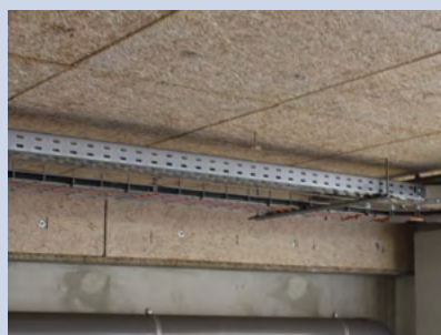
Isolant du sous-sol réalisé en fond de coffrage
