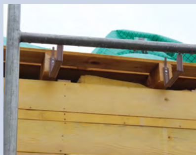
Partie de l'ITE mal protégée de la pluie
