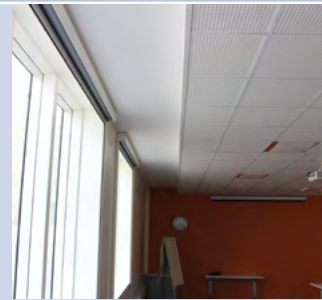
Accès à l'inertie du béton
