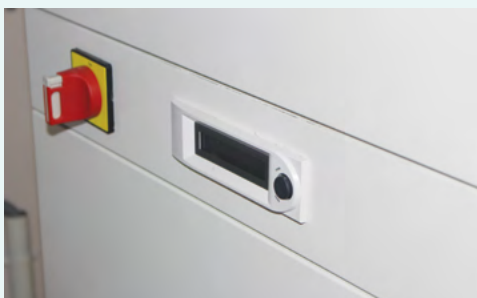
Système d'alerte de panne ou de changement de filtre de la PAC
