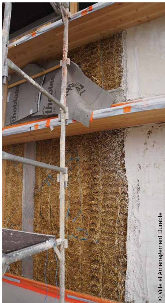
Enduit à la chaux minérale appliqué sur la paille
