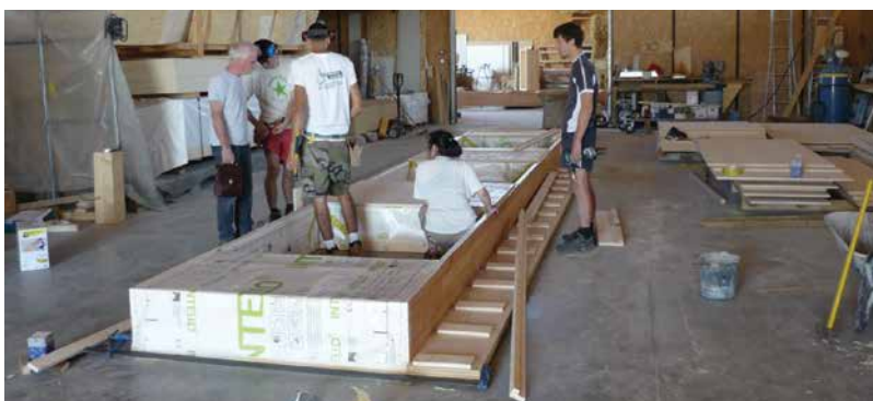
Atelier d'assemblage des murs caissons
