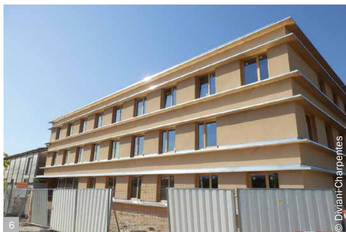
1 et 2. Terrassement et fondations du bâtiment 3. Structure béton nue 4. Structure béton + mur caisson bois/paille 5. Enduit sur façade 6. Enduit de finition sur façade
