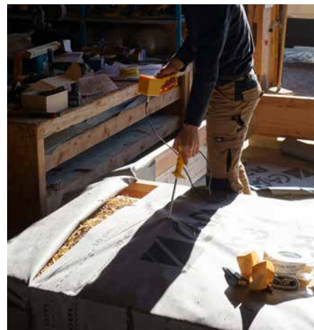
Contrôle de l'humidité de la paille du mur et pare-pluie temporaire
