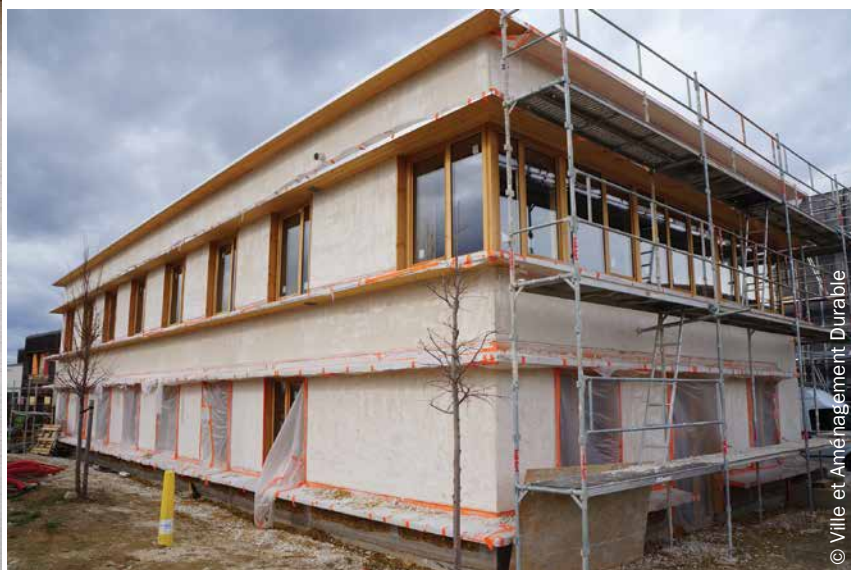
Des casquettes sur toute la longueur du bâtiment permettent d'éviter le ruissellement direct de l'eau de pluie sur la façade
