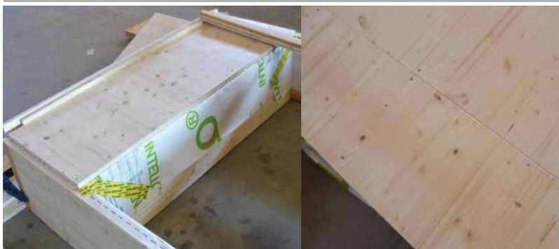
Panneaux de contreventement et parement intérieur final
