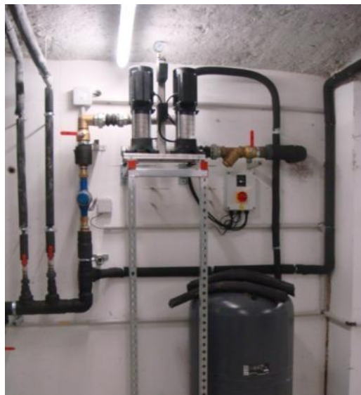
Surpresseur : alimentation des toilettes depuis cuve de récupération d'EP
