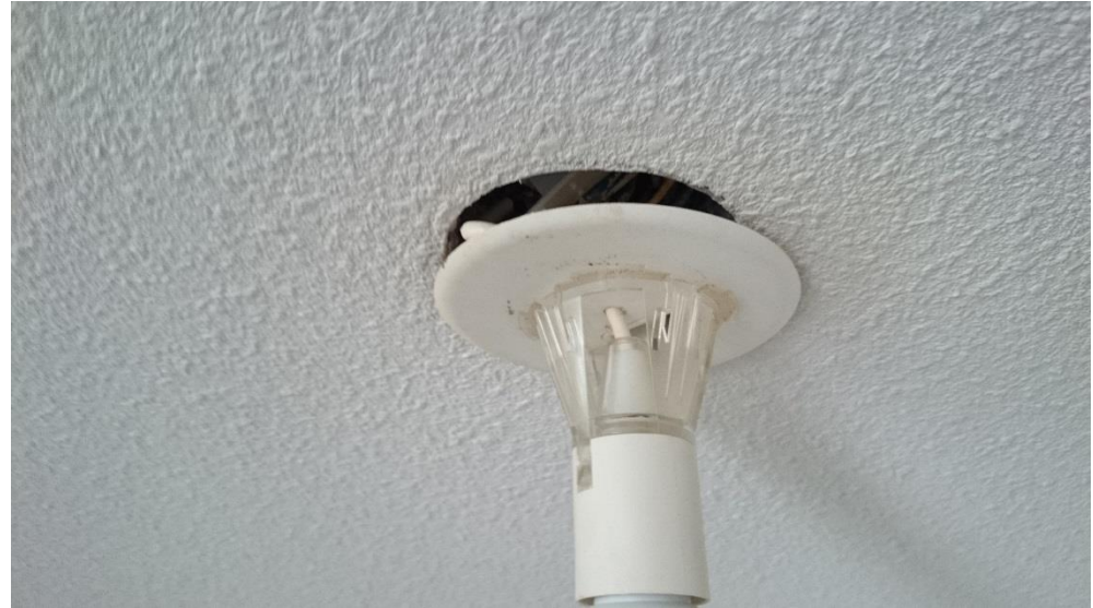
Renforcement des fixations des points lumineux
