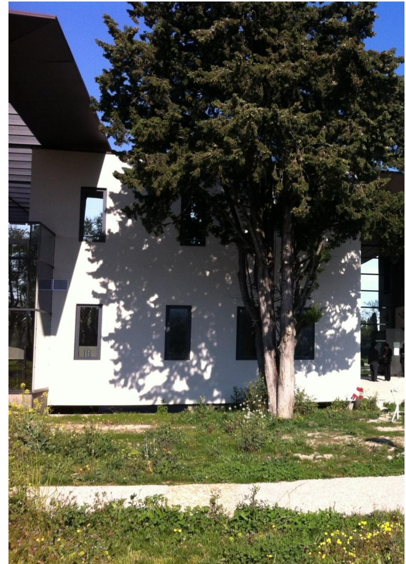
Conservation de la végétation façade Sud
