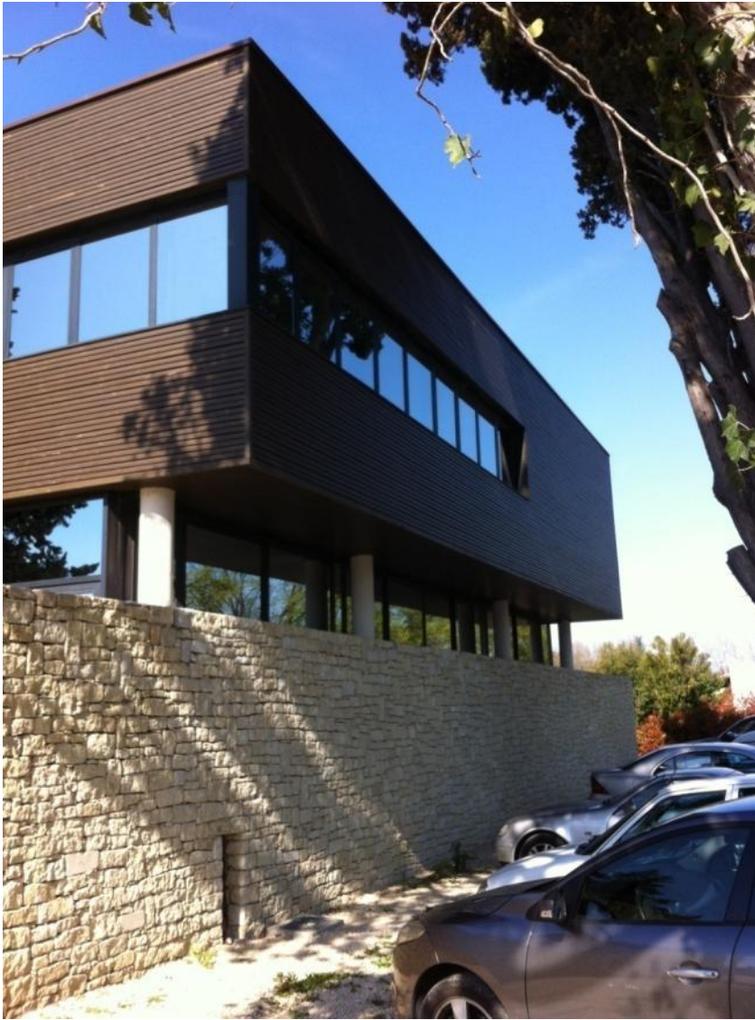
Conservation de la végétation façade Est
