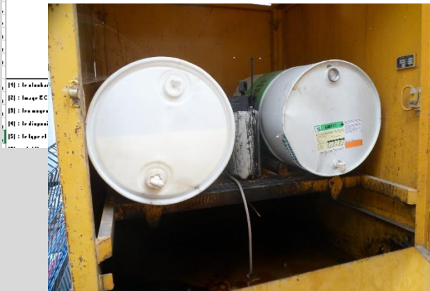
Stockage produits dangereux sur rétention
