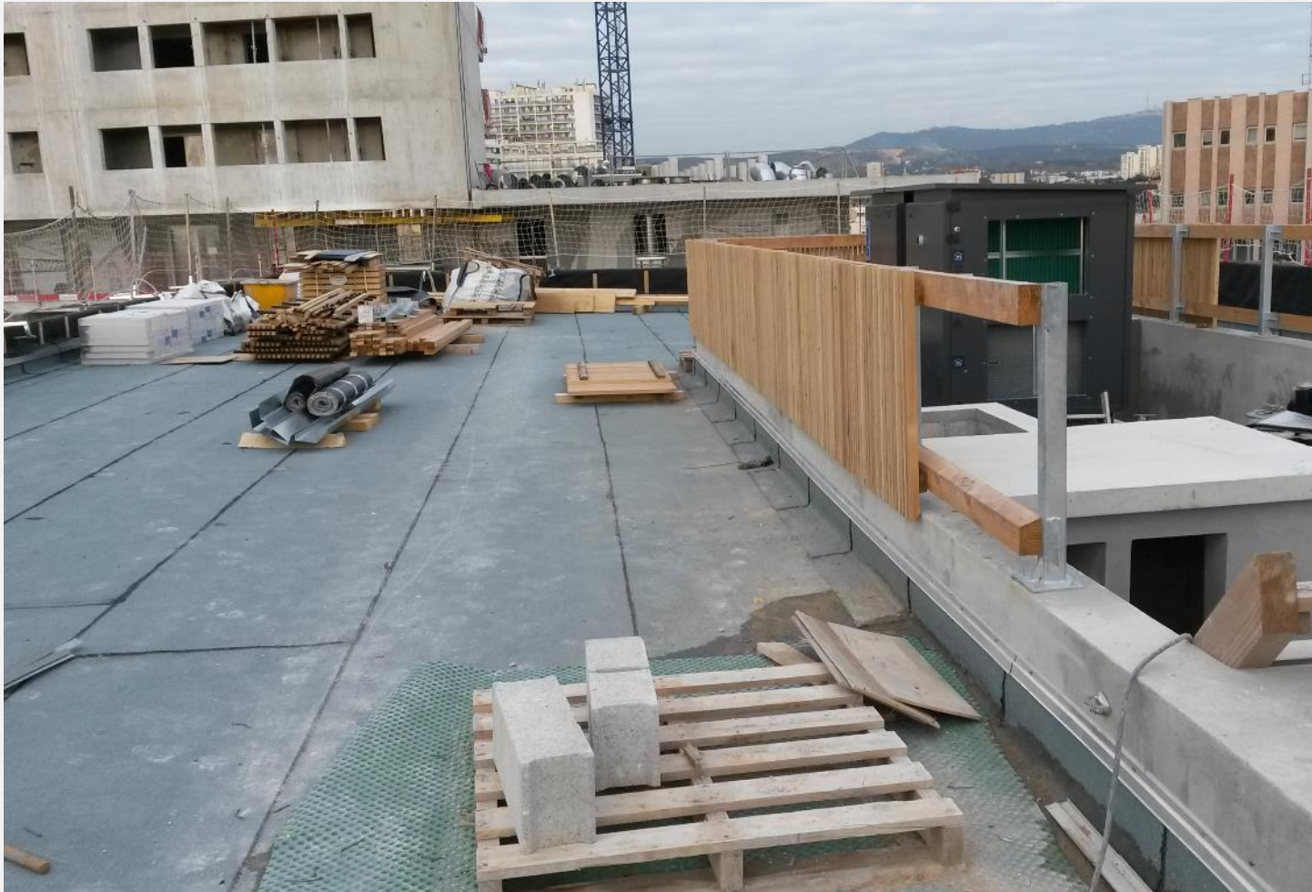
Travaux en toiture
