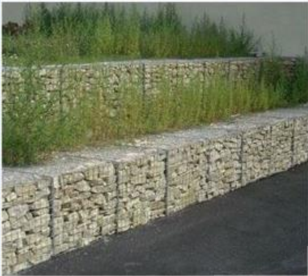
Restanques en gabions
