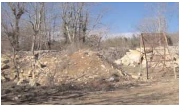
Terre et roches sont extraites du site puis triées par crible mécanisé actionné par tractopelle
