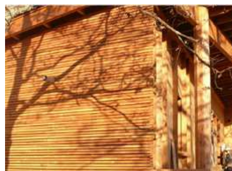
Détail du bardage et débord de toiture d'un logement
