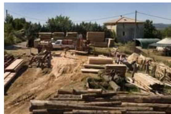
Vue sur le poste de sciage à l'entrée du Hameau. Le bois est une ressource locale qui vient du département
