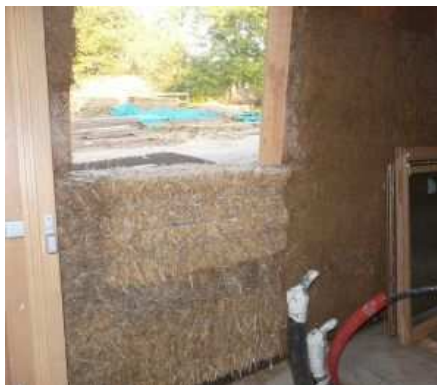
Isolation avec ballots de paille
