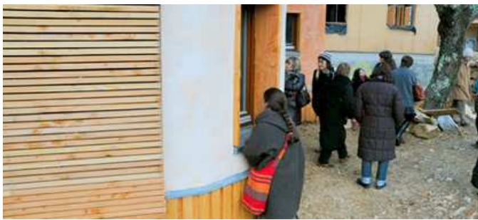
Visite hebdomadaire du chantier ouverte à tous © Xavier Pagès
