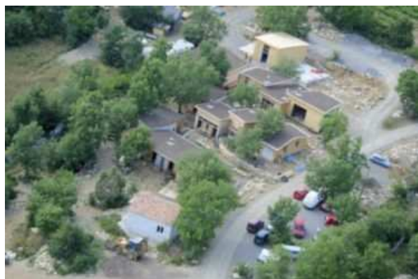
Insertion des logements dans le site © Le Hameau des Buis
