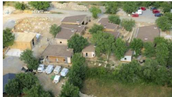
Vue aérienne des toitures semées de Sédums (plantes locales) des bâtiments
