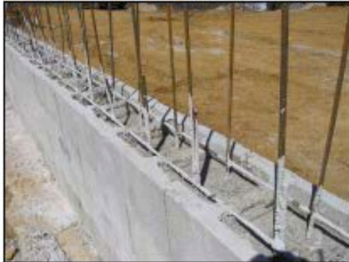
MUR DE REFEND BETON BANCHE
