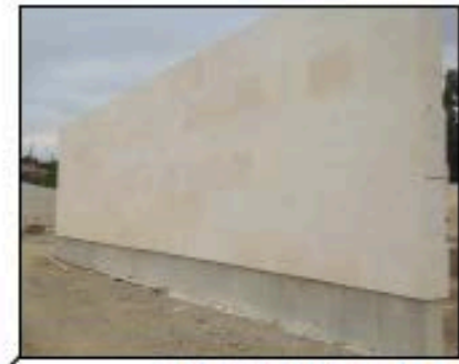
MUR ENVELOPPE PIERRE DE CASTILLON-DU-GARD
