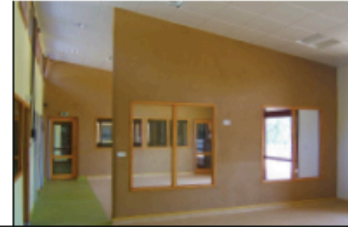
ENDUIT TERRE SUR MUR PAILLE
