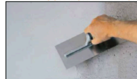
ENDUIT PLÂTRE SUR MUR EN BETON
