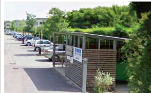
Exemple d'abris implanté en limite parcellaire d'un îlot
