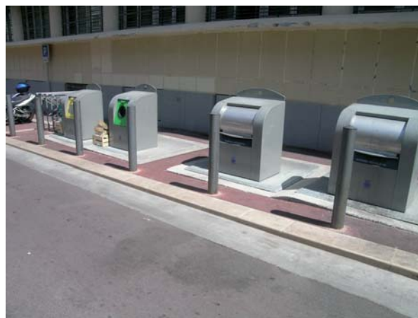
Mieux gérer le tri. Conteneurs à déchets enterrés - place Lulli
