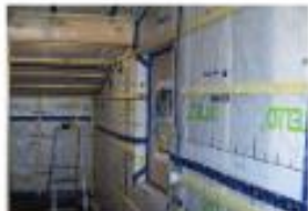
Membrane étanchéité
