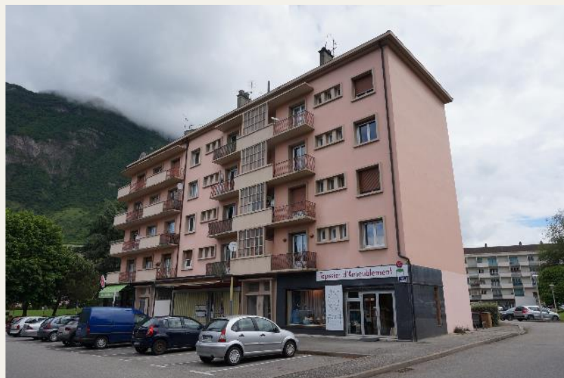
Façade nord et pignon ouest
