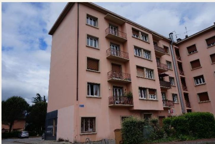
Façade sud et pignon ouest
