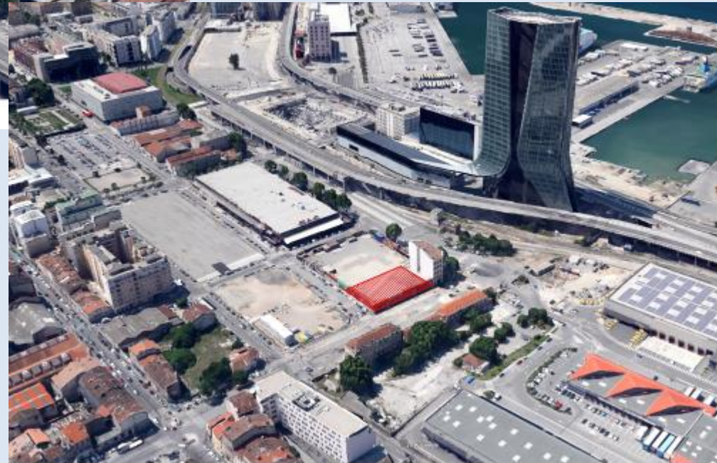
Vue aérienne 3D depuis le Nord
