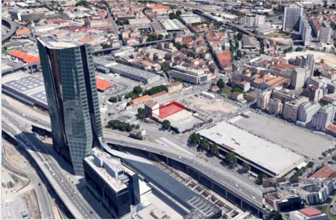
Vue aérienne 3D depuis le Sud
