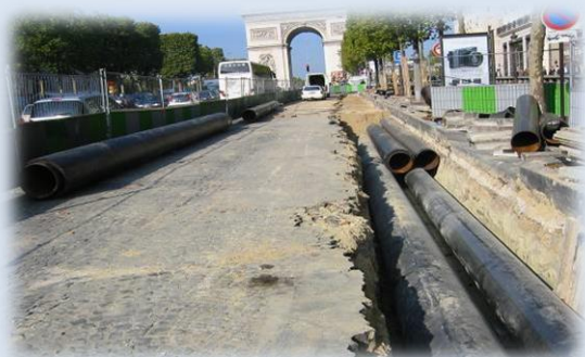
Réseau de distribution enterré ou en galerie
