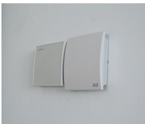
▲ Figure 14 : Sondes de température ambiante pour montage mural, sous capot
