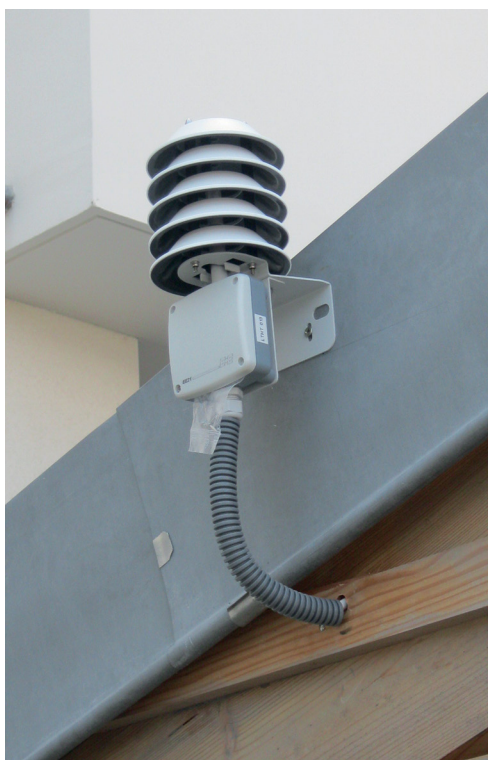
▲ Figure 6 : Sonde de température extérieure sous protection à coupelles
