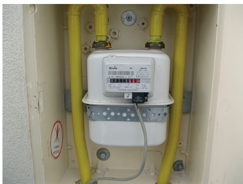
▲ Figure 49 : Compteur de gaz équipé d'un émetteur d'impulsions
