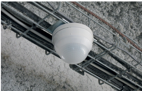
▲ Figure 18 : Détecteur de mouvement pour montage au plafond
