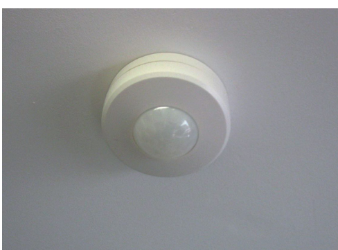
▲ Figure 19 : Cellule de mesure de l'éclairage intérieur
