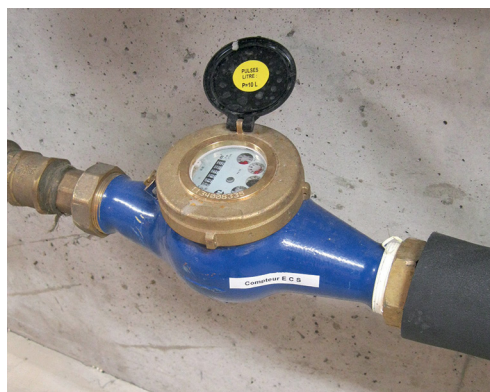
▲ Figure 28 : Compteur d'eau à jets multiples
