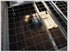
Installation solaire existante (150m²) maintenue et légèrement optimisée (pilotage par la GTC), stockage dans 2 ballons solaires de 5000l et appoint par la chaufferie bois en hiver
