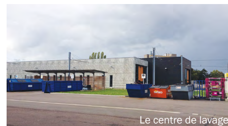
Le centre de lavage
