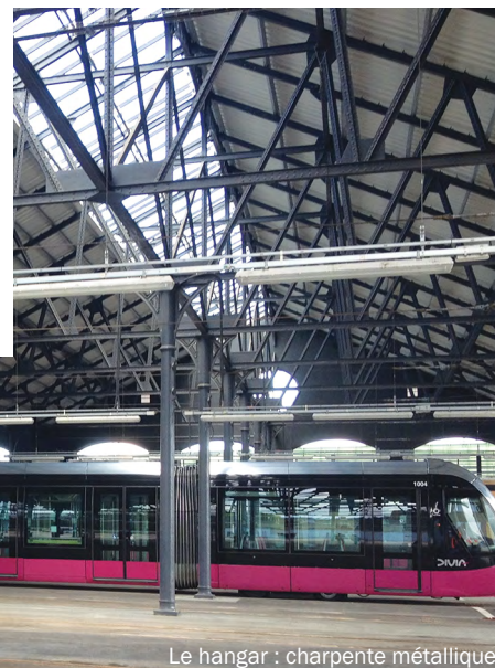
Le hangar : charpente métallique
