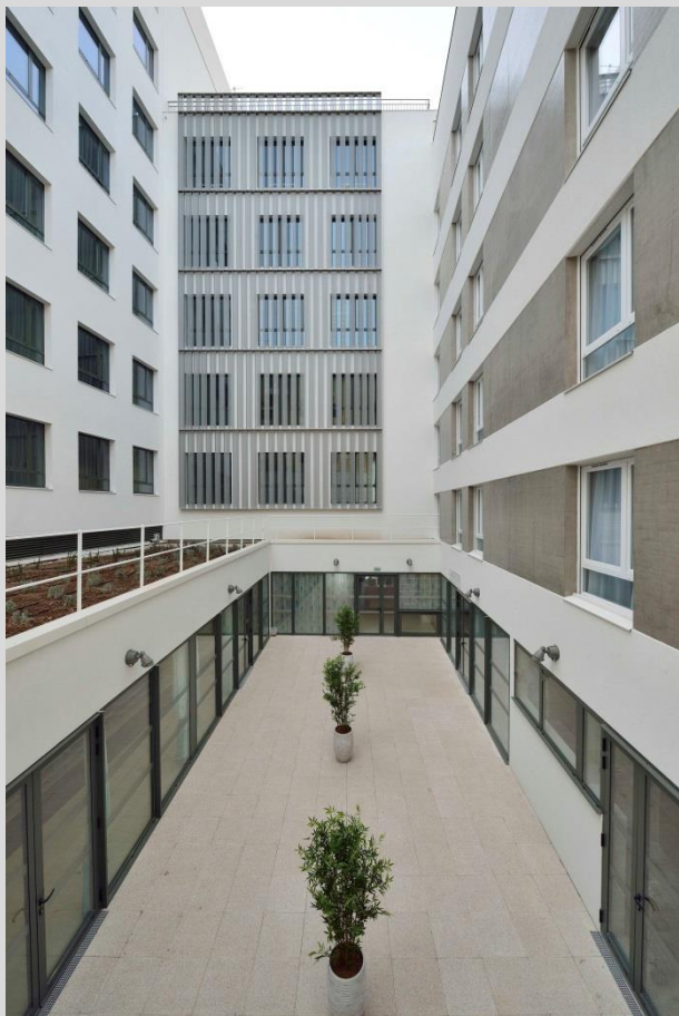
Façade nord et est sur patio
