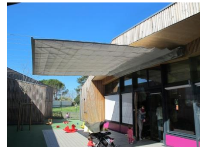
12 Les protections solaires sont mobiles
