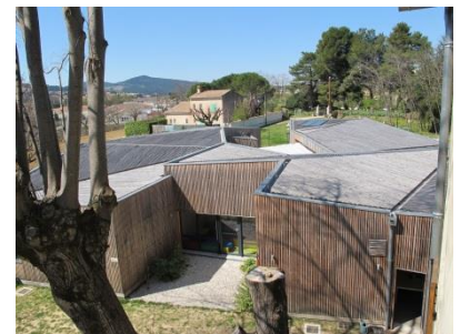
6 Vue sur la toiture en bardage bois ajouré
