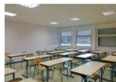
L'ouverture des fenêtres dans les salles de cours est parfois limitée.
